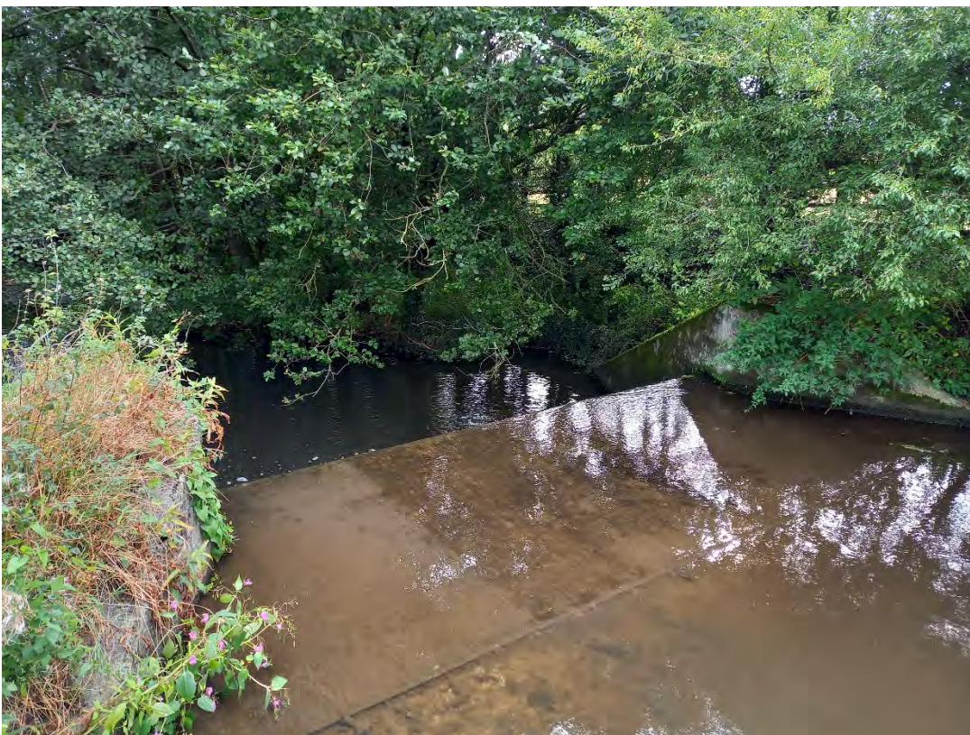
Figure C-31 Site 54 DS Impact
